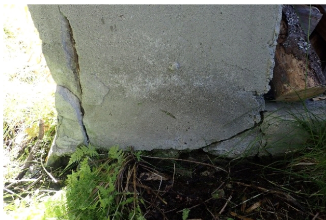
Betongskader på pilarer m.m.
