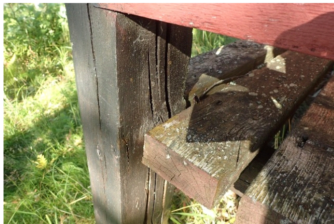
Råteskadet trapp/veranda.
