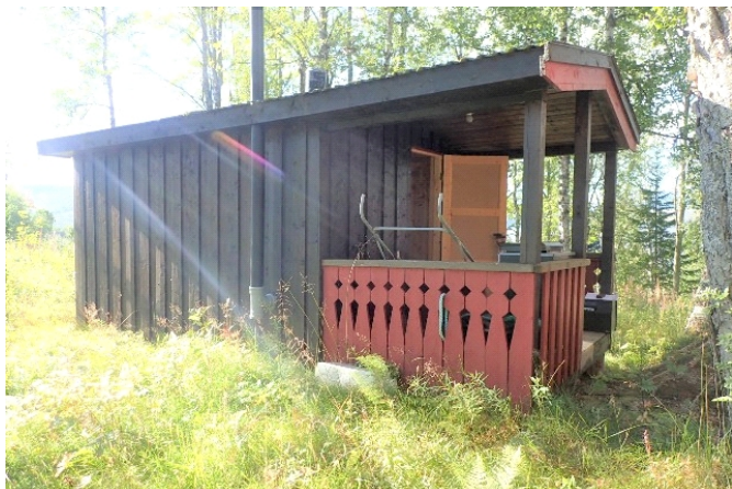
Uthus: Fasade mot øst.
