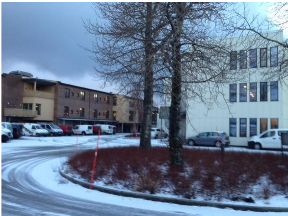
Figur 11: Brønnøy Helsecenter, sett fra sør, med vareinngang
